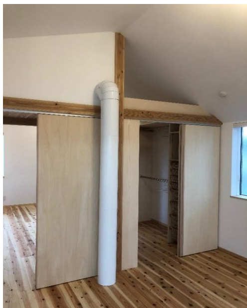
ラッキングカバー施工例
