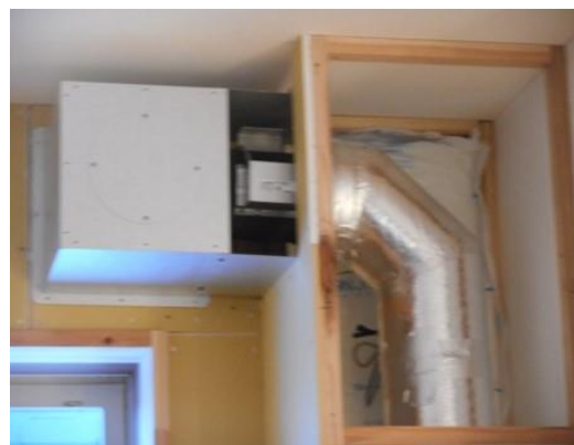
電動ダンパー側面設置の例
