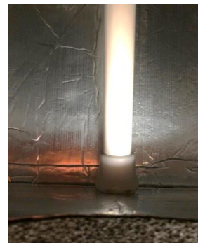
ダクト接続ボックス底面に固定
