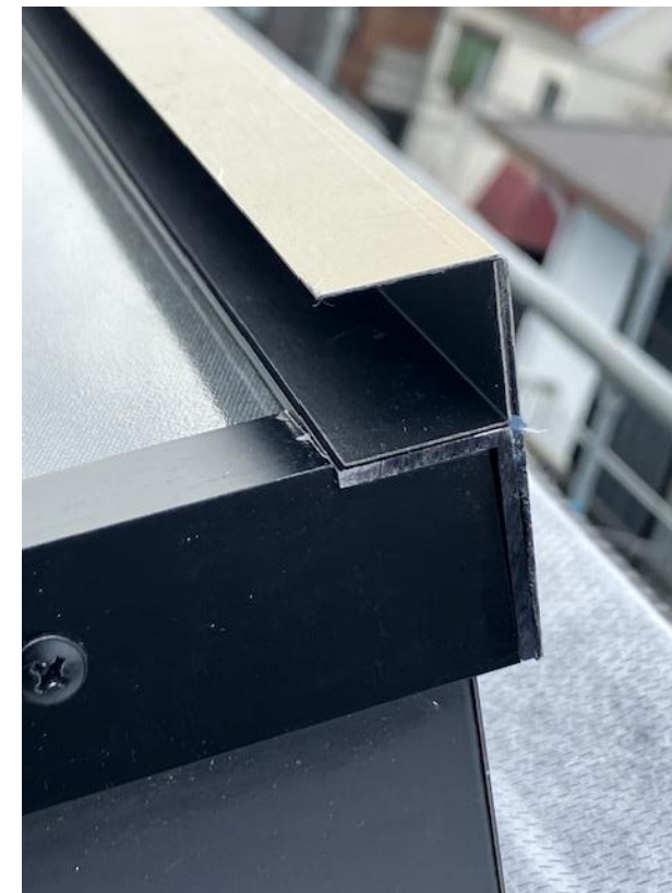
水上側止水板とガラス押えアルミアングルの接合部を完璧にカバーするための補強板
