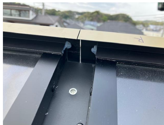
水上側止水板とガラス押えアルミアングルの接合部を完璧にカバーするための補強板
