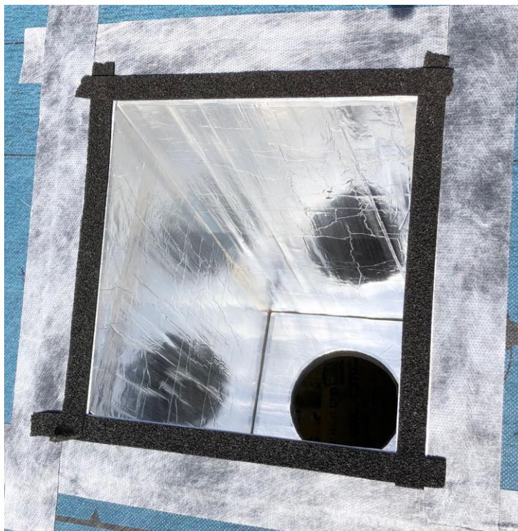
ダクト接続ボックス開口部の防水処理
