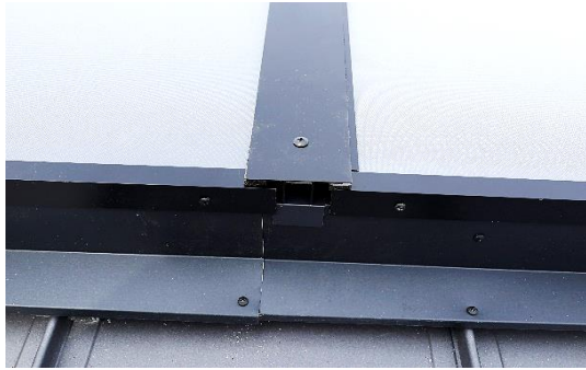
集熱パネル連結部・水下側納まり
