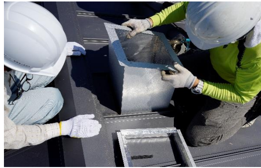
ダクト接続ボックス取付
