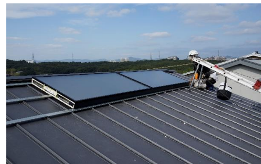
集熱パネル(R+C)取付
