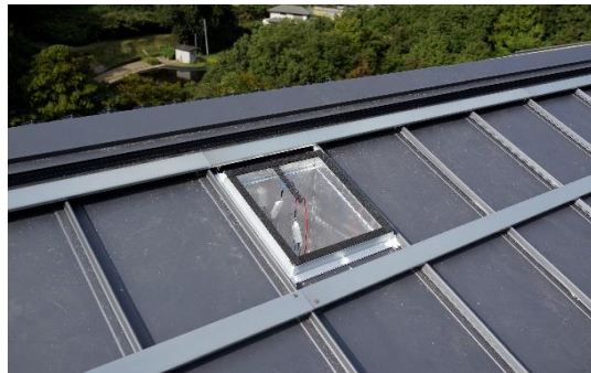
横レール設置
