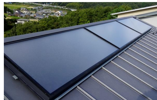
集熱パネル設置完了
