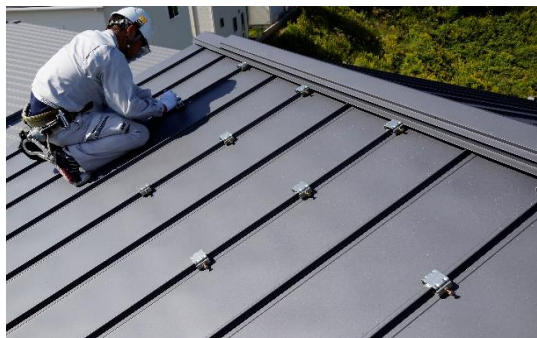
嵌合立平葺き用取付金物設置
