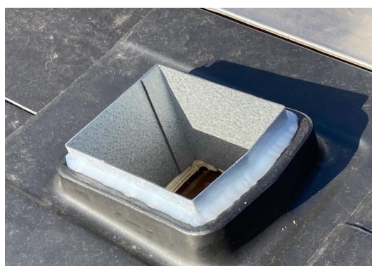
ダクト貫通部の止水対策
