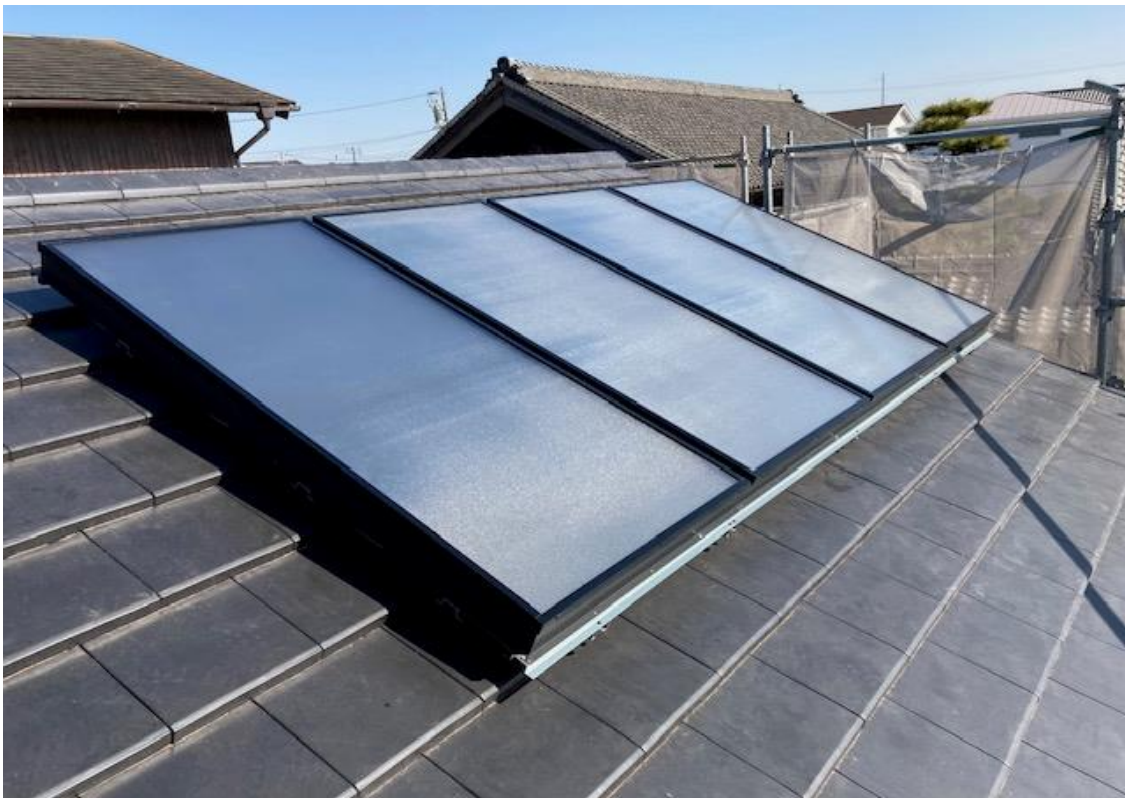
架台上への集熱パネル設置完了
