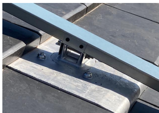
支持瓦へ縦レール取付け
