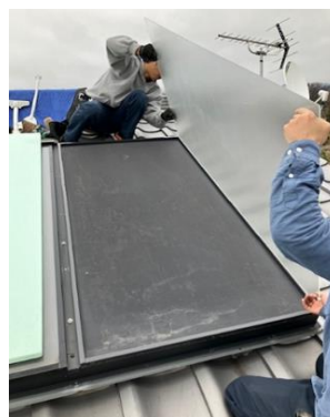
交換作業の様子
