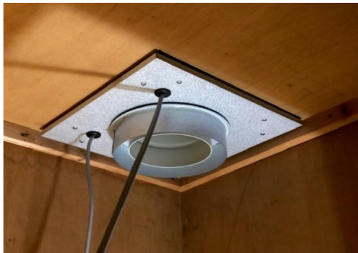
天井断熱用電動ダンパーボックス施工
