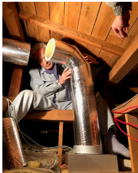
GWダクト接続中
