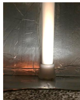
ダクト接続ボックス底板に固定
