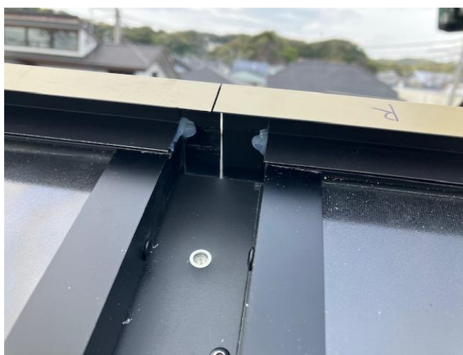
水上側止水板取付状況
