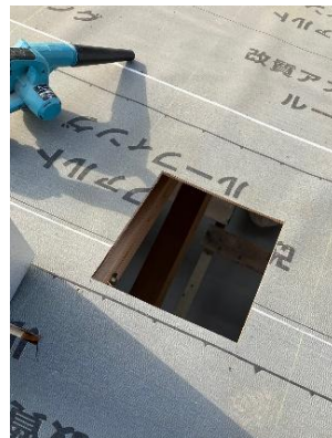
ダクト接続ボックス用開口
