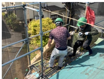
集熱パネルにロープを掛けて引っ張り上げる
