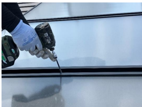
縦型パネル連結部の長ビス打ち
