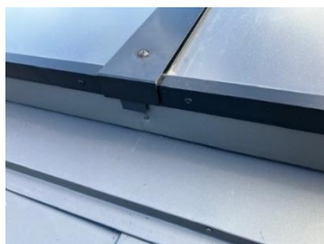
流れカバーの設置状況
