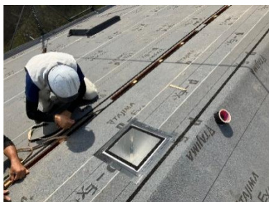
気密テープの施工
