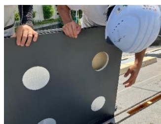
ダクト接続口を開口
