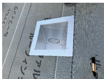
ダクト接続ボックス設置状況
