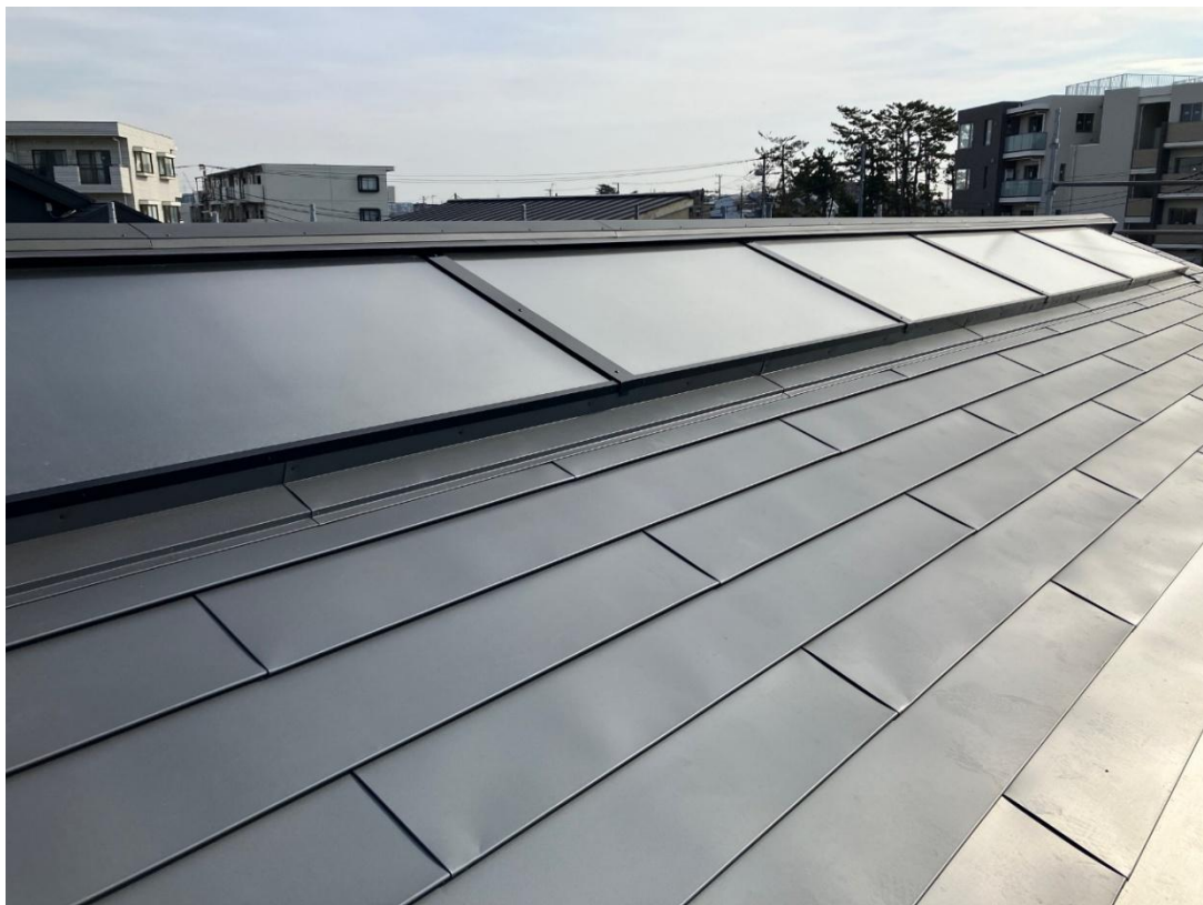
集熱屋根工事完了
