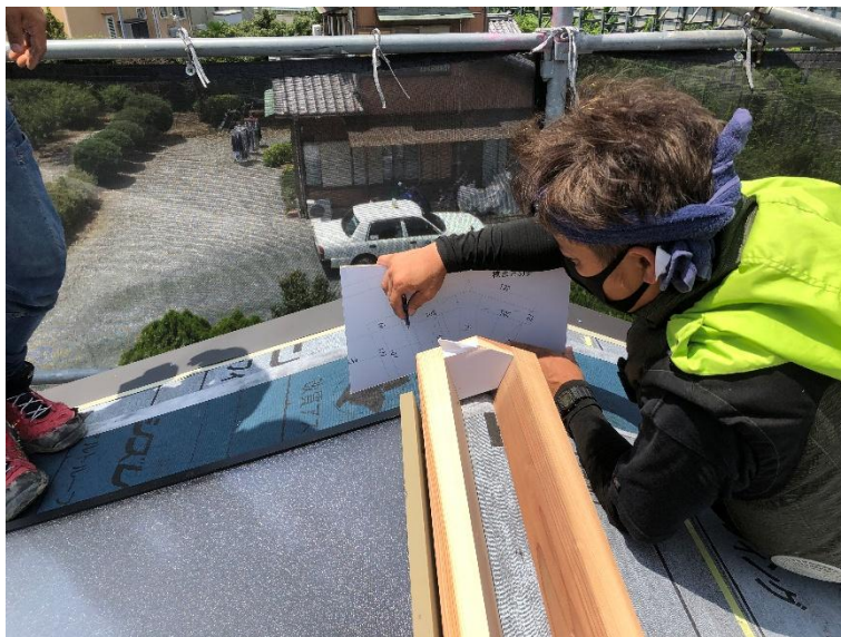
棟下地の施工
