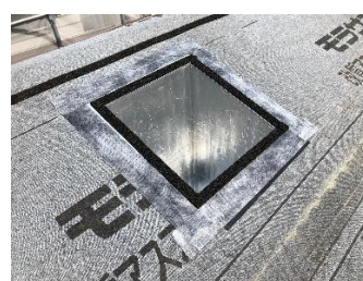
ダクト接続ボックスの防水処理
