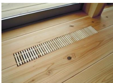
木製床吹出口施工例
