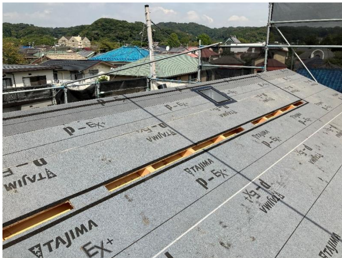
【B】屋根通気層を利用した予備集熱面＋集熱パネルの施工事例
