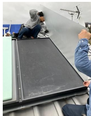
交換作業の様子
