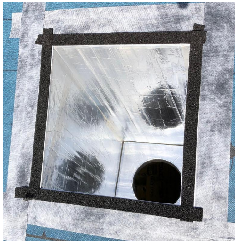
ダクト接続ボックス開口部の防水処理
