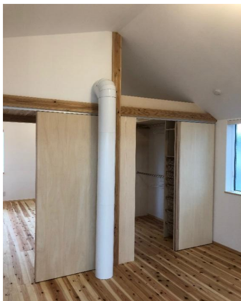
ラッキングカバー施工例
